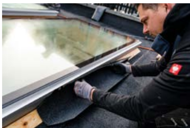
Aanbrengen dakbedekking
