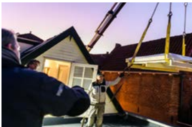
Plaatsen nabij raveling. Hijsstroppen onder de pallet
