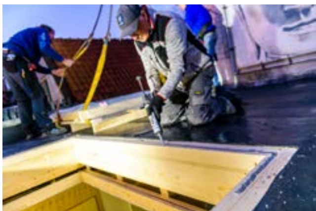
Aanbrengen kit op randbalk
