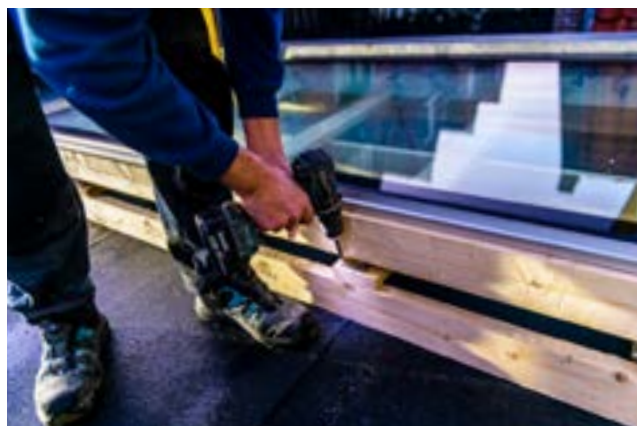
Losschroeven van de pallet
