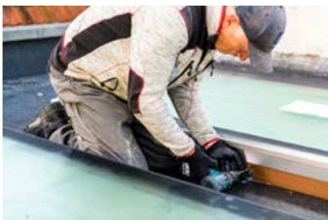
Vastzetten daklicht aan dakconstructie
